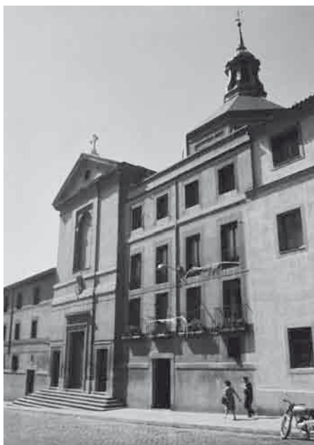
Fachada de la iglesia de Santa Isabel.
