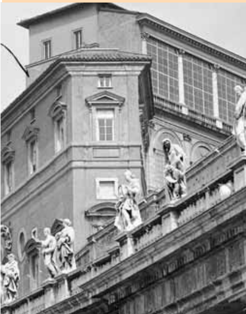
Aspecto da fachada antiga do edifício, vendo-se a janela na esquina.
