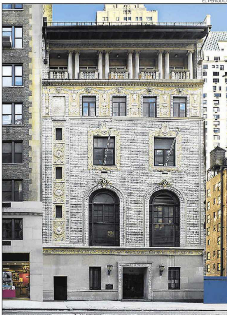
►► La nueva sede del IESE en Nueva York, todavía en obras.
